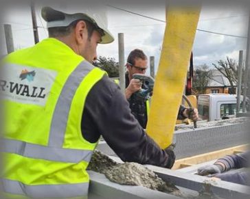
4. Pour concrete into formwork
